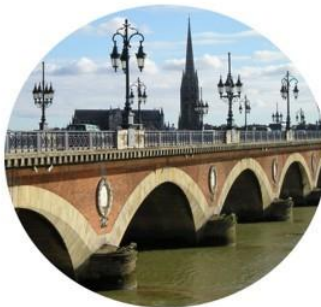
Pont de pierre à Bordeaux
